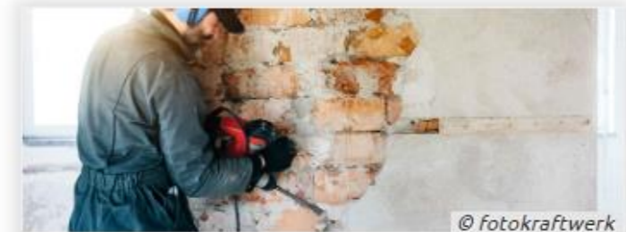
Sanierungsprofis auf einen Blick
